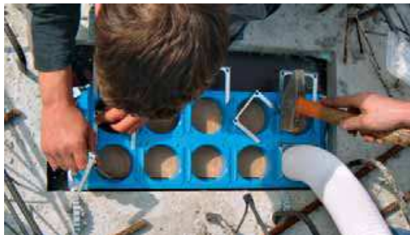
Obr 10: Napojenie hadíc na prírubu pomocou strmeňov
