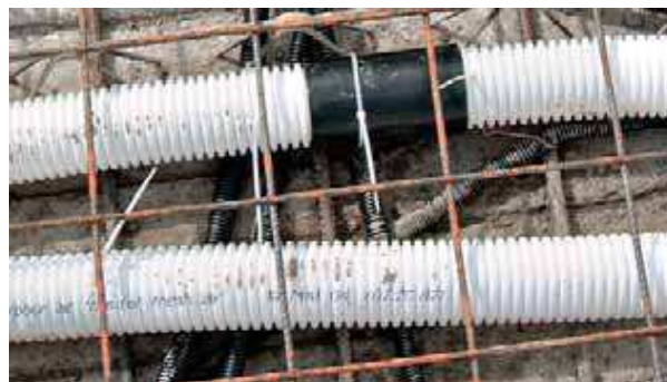
Obr. 7: Spojka pre nadpojenie flexi hadice
