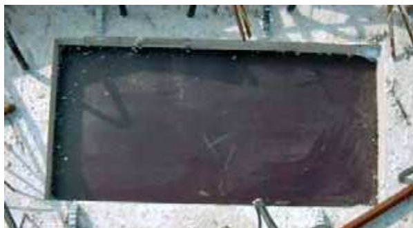
Obr. 4: Príprava a vyčistenie otvoru pre prírubu
