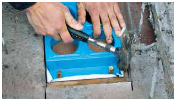
Obr. 6: Zaistenie príruby klincami
