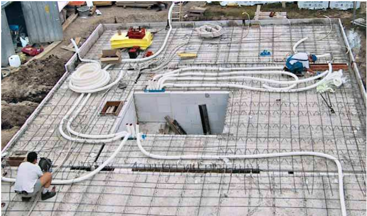
Obr. 1: Umiestnenie rozdeľovačov a hadíc
