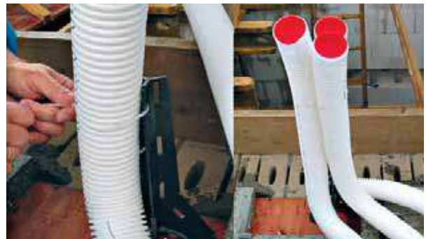
Obr 13: Hadice fixované na kotviacom prvku
