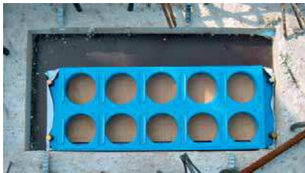
Obr. 5: Zaistenie príruby
