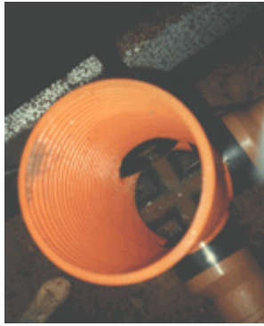
Obr. 2 - Sběrač s drenáží a vstup do domu
