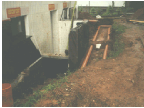
Obr. 3 - Dvě paralelní trubky zemního výměníku tepla umístěné 2 m vedle základové konstrukce
